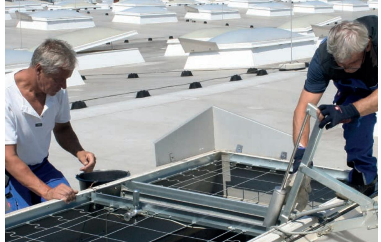
Einsatz der ESSMANN Ab- und Durchsturzicherung in einem Aufsetzkranz in Kombination mit Natürlichem Rauch- und Wärmeabzug.
